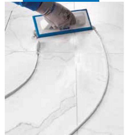
Aplicación de Ultracolor Plus en pavimento con llana de goma sobre baldosas de gres porcelánico efecto mármol
